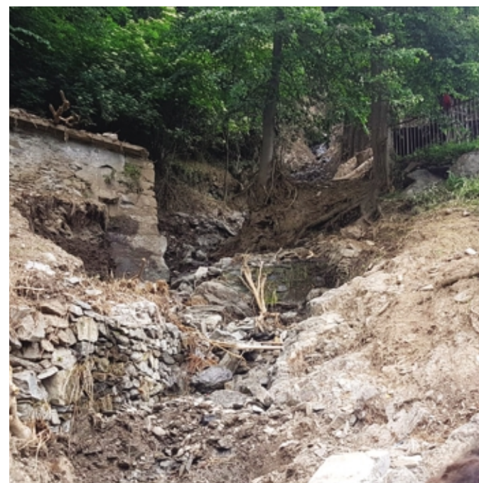
L'immagine di una frana montana dovuta alle piogge torrenziali
