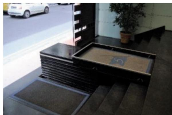
Soluzione con elevatore a gradino elettroidraulico
