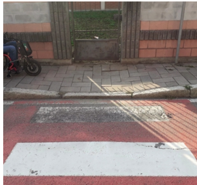
Raccordo marciapiede/strada con barriera
