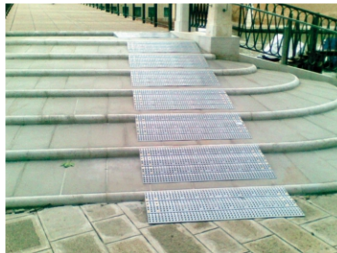
Rampe componibili per ovviare ai gradini
