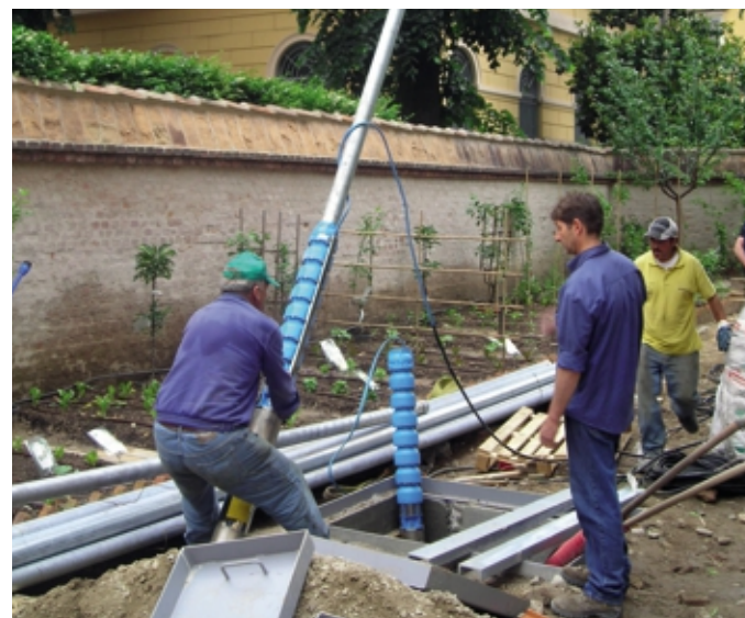
La realizzazione di un impianto geotermico
