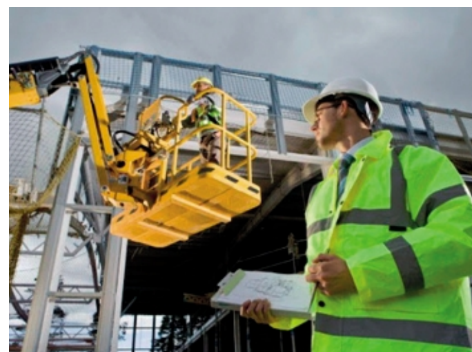
Professionisti al lavoro in cantiere
