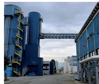
Centrale Lamarmora di Brescia
