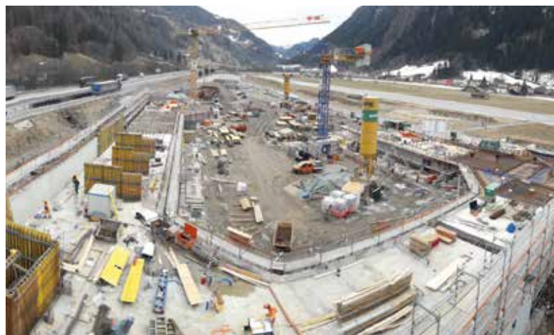
Nelle immagini i lavori preliminari del cantiere
