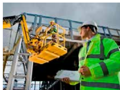
Professionisti al lavoro in cantiere
