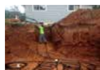
Interventi di geotermia
