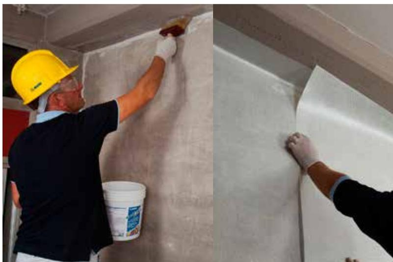
Il sistema **MapeWrap EQ System** è stato studiato per prevenire la caduta degli elementi non strutturali, come gli intonaci o i muri di tamponamento, durante le prime scosse e aumentare così il tempo di evacuazione dagli edifici.
