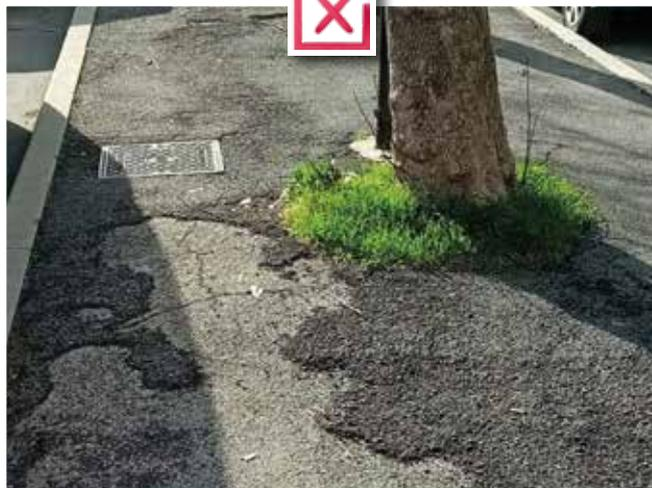
Sopra la pavimentazione sconnessa di un marciapiede che impedisce ad una carrozzina di scorrere.
