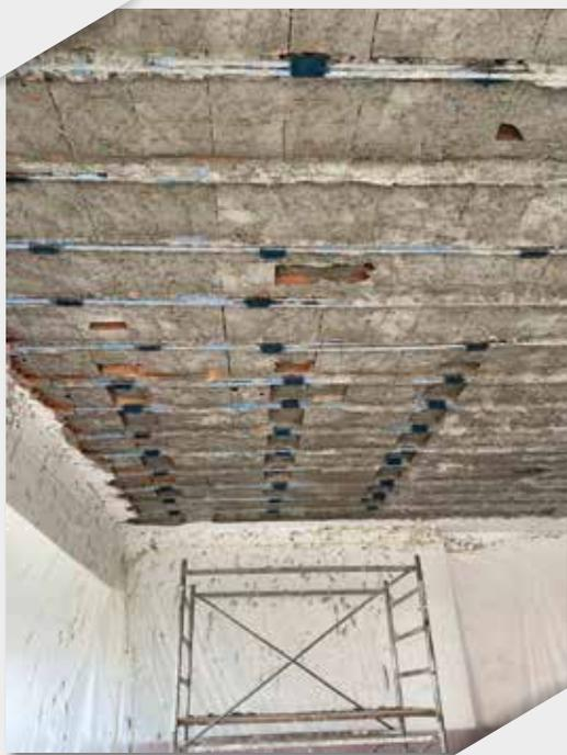
Nelle immagini a fianco, l'intervento di messa in sicurezza contro sfondellamento di solaio di copertura all'I.T.E.S. Caio Plinio II di Como in via Italia Libera mediante passivazione galvanica e armature con anodi sacrificali, stollatura e ricostruzione controsoffitto a quadrotti in lana minerale. Lavori eseguiti quest'anno.
