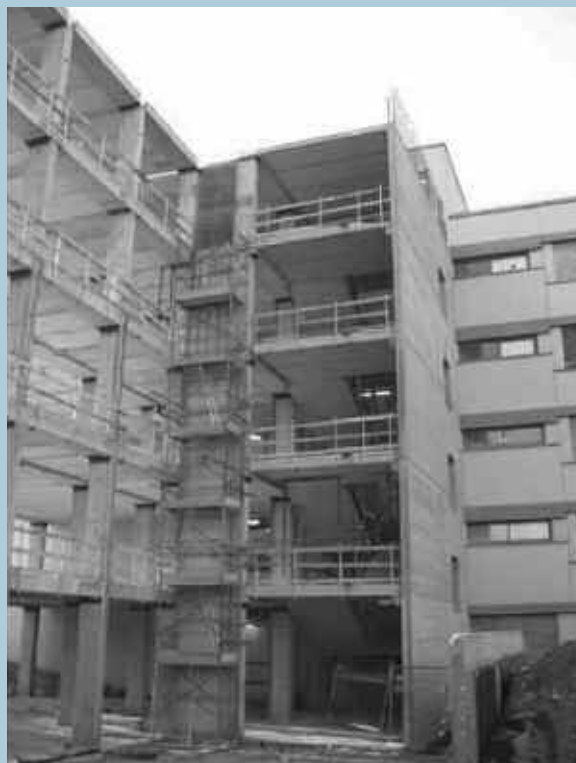
Particolare dell'unione con l'edificio esistente
